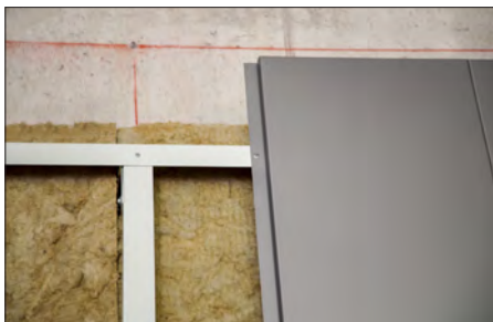
Abb. 49 Profile bei senkrechter Montage
