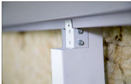
Abb. 43 Fixgleithafter: ohne Niete (äußeren)
