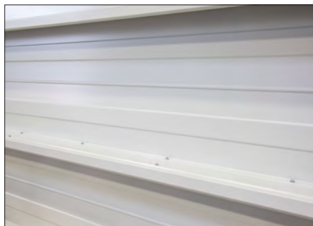
Abb. 70 Verschraubung der Kassetten
