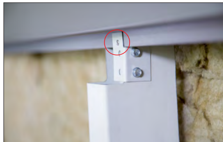
Abb. 44 Fixpunkthafter: Vernietung mit Planum-Profil (mittleren)
