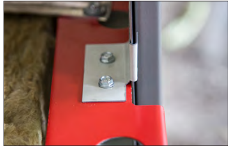
Abb. 53 Fixgleithafter Detail
