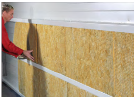
Abb. 73 Kassetten-Innenschale mit Wärmedämmung
