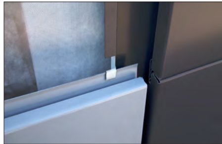
Abb. 39 Sicherung gegen Aushängen - Feder nach unten biegen
