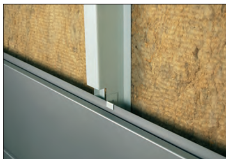
Abb. 37 Fixgleithafter bei Planum waagrecht als Sicherung
