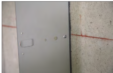
Abb. 24 Ausgleichswinkel auf Betonwand
