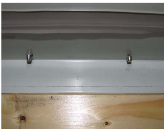
Bild 5 Nietung längs – Ansicht von innen
