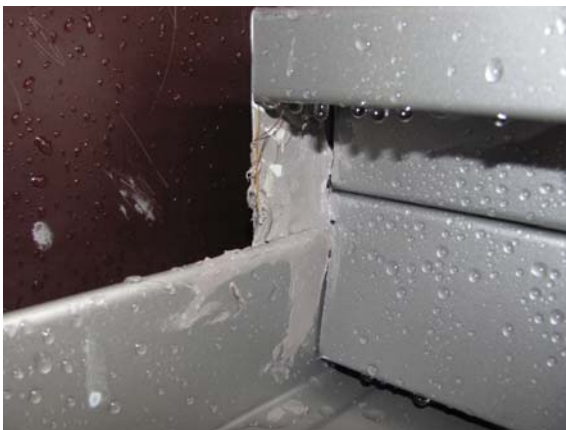
Bild 9 Abdichtung Profilbahn / Halbfirstabdeckung und Zahnleiste an Prüfungsaufbau – Ansicht von außen
