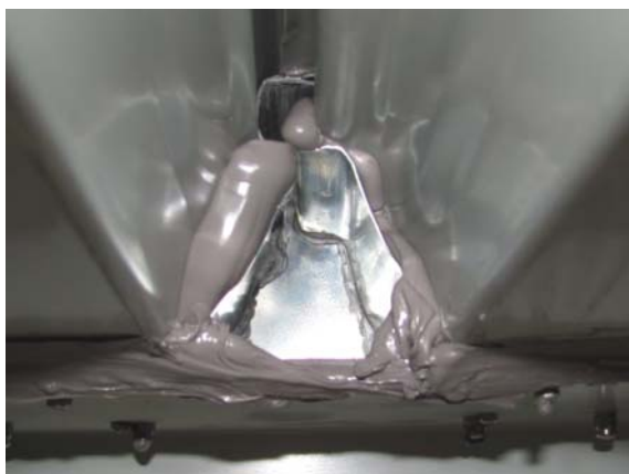
Bild 3 Abdichtung Profilfüller Domitec® Profilbahn – Ansicht von innen
