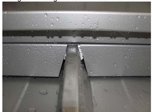
Bild 10 Zahnleiste / Profilbahn – Ansicht
