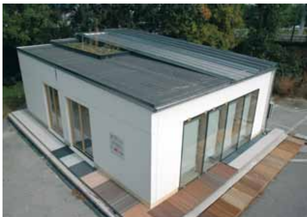
Abbildung 1: Dachansicht Haus A „besontnt“
